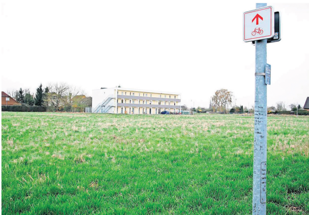
Ein Gebäude steht schon: Das als Flüchtlingsheim errichtete Gebäude auf der Grünfläche an der Tiefen Straße wird in das geplante Gartenquartier integriert.
